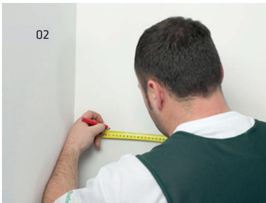
Позначте місця, в яких будуть прикріплені дерев'яні конструкційні рейки з мінімальними розмірами перерізу 18 мм x 50 мм. Першу рейку прикріпіти на відстані максимум 10 см від внутрішнього або зовнішнього кута.
