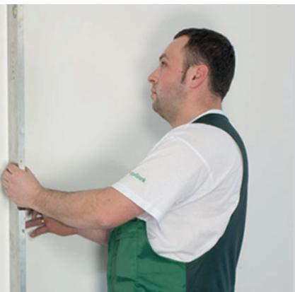
Перевірте площинність стіни за допомогою будівельного рівня. Відхилення не повинно перевищувати 2 мм на довжині 2 м.
