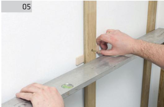
Рейки повинні створювати одну площину. Це слід перевірити за допомогою будівельного рівня, що прикладається на ширині мінімум 3 рейок. При необхідності вирівняти конструкцію, використовуючи, наприклад, фанеру.
